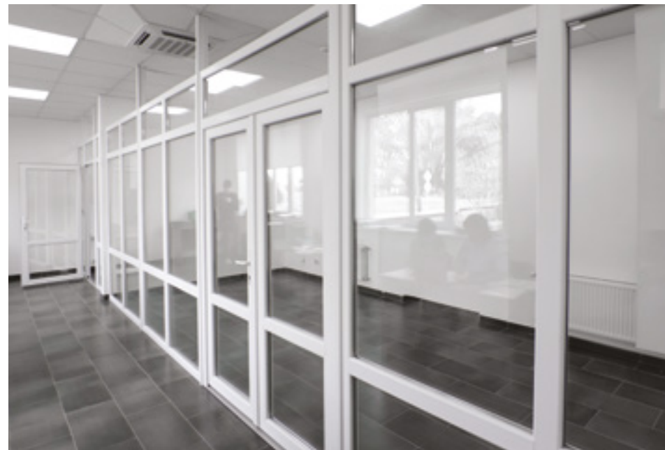
• Виконання металопластикової перегородки у ЦНАП в Вишнівській ТГ
