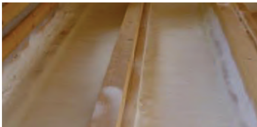
Рисунок. Утеплення пінополіуританом. Утеплення горища мінераловатними плитами.
