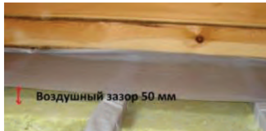
Рисунок. Утеплення пінополіуританом. Утеплення горища мінераловатними плитами.
