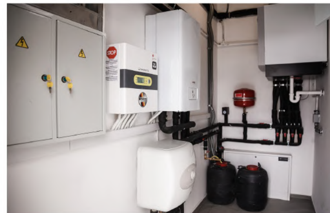
Система теплового насосу "повітря/вода"
